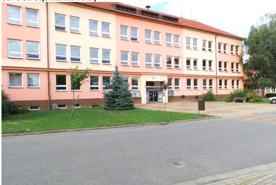
Obr. č. 31: Objekt základní školy
