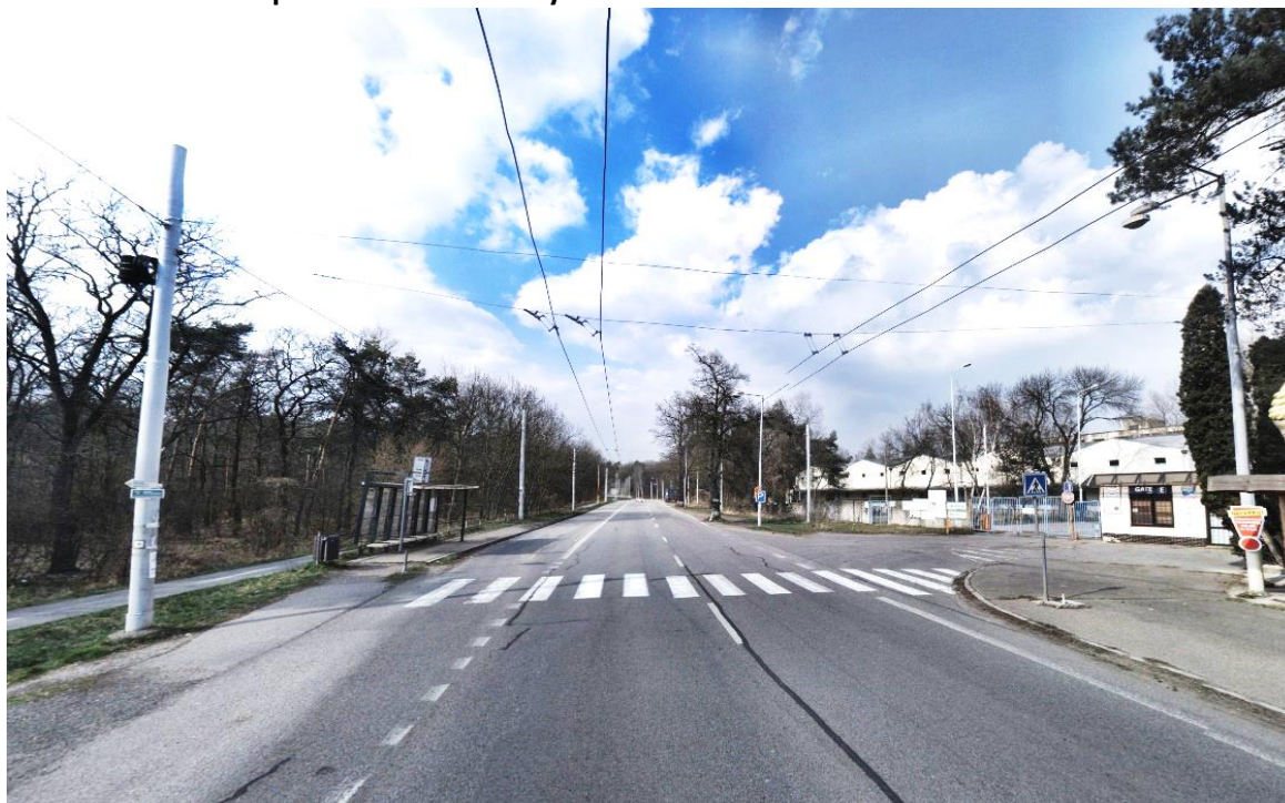
Obr. č. 27: Přechod pro chodce nasvícený z obou stran
